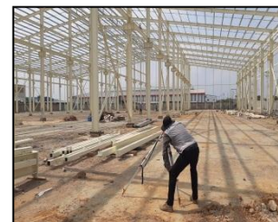
CÔNG TÁC GIA CÔNG VÀ LẮP ĐẶT KẾT CẤU THÉP
