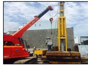
CÔNG TÁC TẠM VÀ ÉP CỌC
