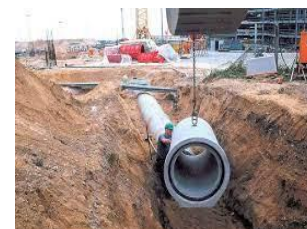
CÔNG TÁC HẠ TẦNG
