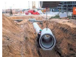
CÔNG TÁC HẠ TẦNG
