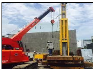
CÔNG TÁC TẠM VÀ ÉP CỘC
