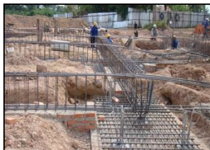
CÔNG TÁC MÓNG ĐÀ
