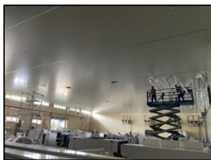
CÔNG TÁC LỢP TÔN VÀ LẮP PANEL
